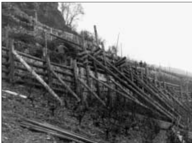
Rochennes: Sicherung alter Rebmauern nach dem «Rutsch».
